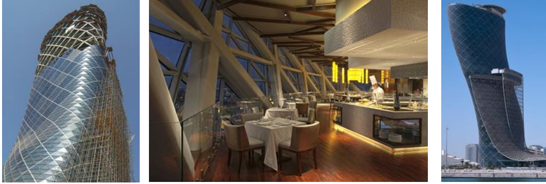
(شكل4) برج بوابة العاصمة دبي Capital Gate ويتضح منه استخدام خامة الفولاذ لتشكيل المبنى وتظهر بداخله كعنصر تصميمي
