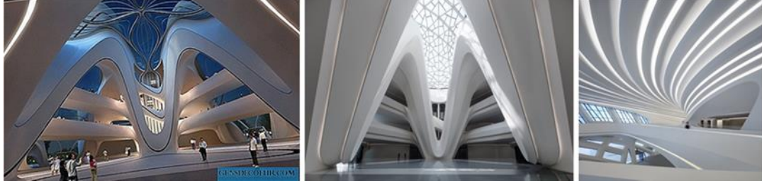
(شكل16) يوضح إستخدام خامة GRC بداخل المبنى وقوة الترابط في التصميم بين الخارج والداخل بنفس الإسلوب
