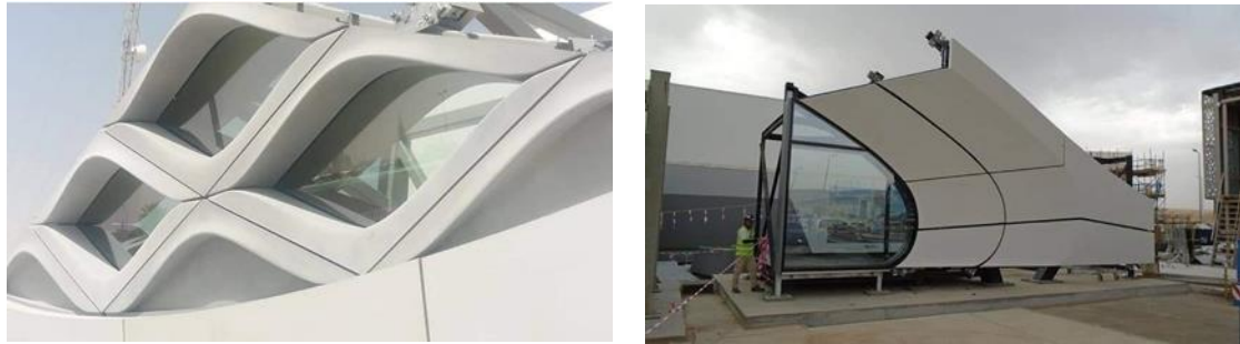
(شكل 12) يوضح تغطية الفولاذ بخامة PVC بعد قولبة الخامة بالتشكيل المطلوب
