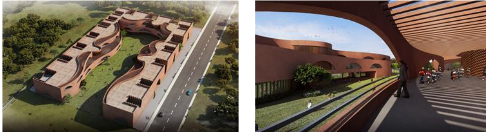
(شكل8) إحدى المباني المستخدمة فيها خامة GRC وهي مدرسة Learning Curves في الهند
