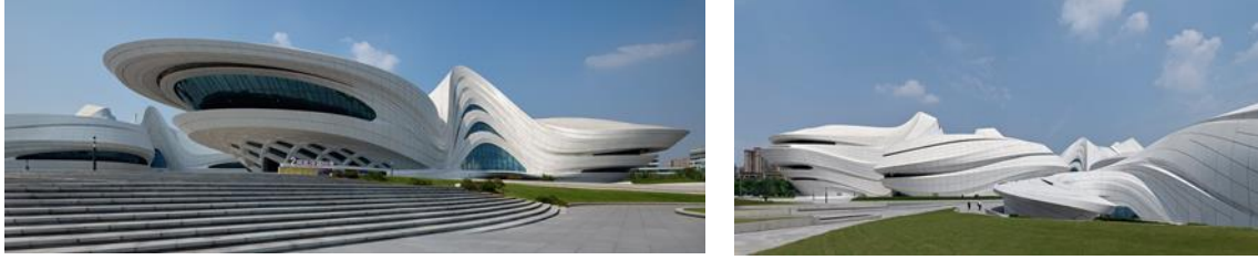
(شكل15) يوضح مبنى Changsha meixihu international من الخارج وإسلوب إستمرارية باستخدام خامة GRC
