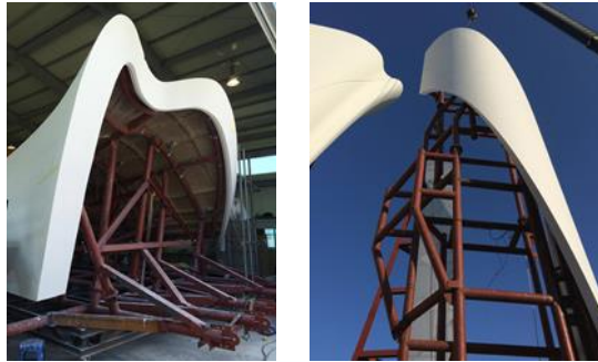
(شكل 21) يتضح من خلاله التشطيب النهائي لخامة الفايبر جلاس بعد طلائها بالتيتانيوم وتجزئها للتركيب.
